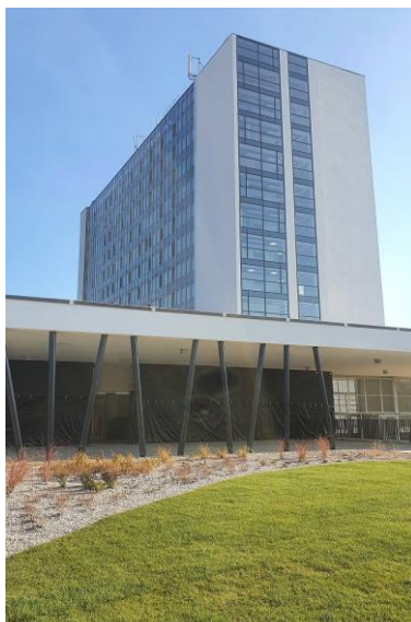
Urgentný centrálny príjem s operačným centrom na miniinvazívne výkony a multifunkčnou chirurgickou JIS – prístavba, rekonštrukcia“ Košice -Šaca Dodávka a montáž elektrických inštalácií
