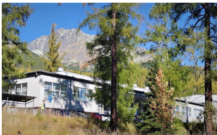
Zvýšenie prevádzkovej efektívnosti energetického hospodárstva NÚTPCHaHCH, Vyšné Hágy Dodávka a montáž elektroinštalácie
